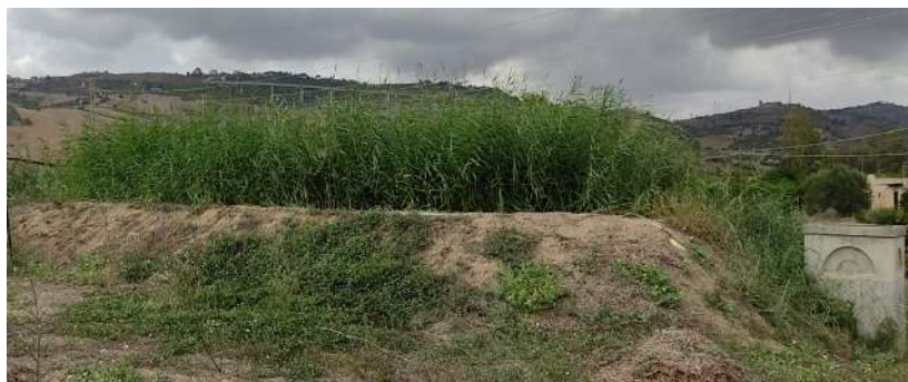
Fig. 7: Letto di fitodepurazione a flusso sub-superficiale verticale (VF) per l'affinamento di una porzione dei reflui prodotti dallo stabilimento ORTOGEL
