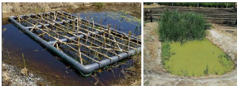
Fig. 8: Vasca di fitodepurazione a flusso superficiale (FWS) per l'affinamento di una porzione dei reflui prodotti dallo stabilimento ORTOGEL, con struttura galleggiante in tubi di PVC vegetata con piante di Typha latifolia .
