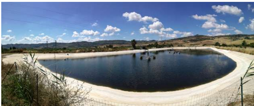
Fig. 2. Serbatoio S3 a servizio dell'azienda ORTOGEL s.p.a. (Caltagirone, Catania) nel quale risultano installati quattro aeratori galleggianti.
